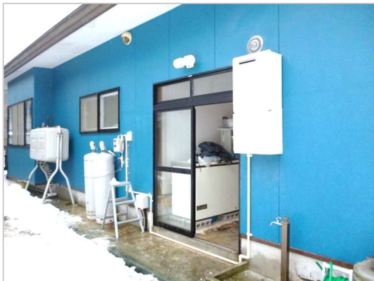
施工例（灯油ボイラーからの変更）
